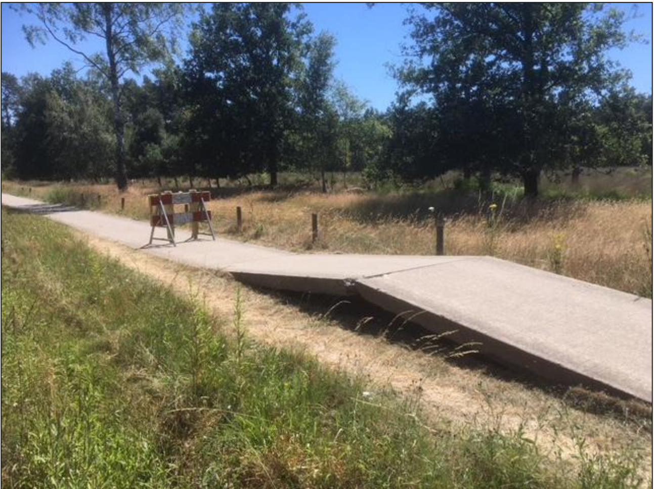
Figuur 11: Hittestress in landelijk gebied: onbegaanbaar fietspad als gevolg van uitzetten van materiaal door hitte (bron: gemeente Bladel)
