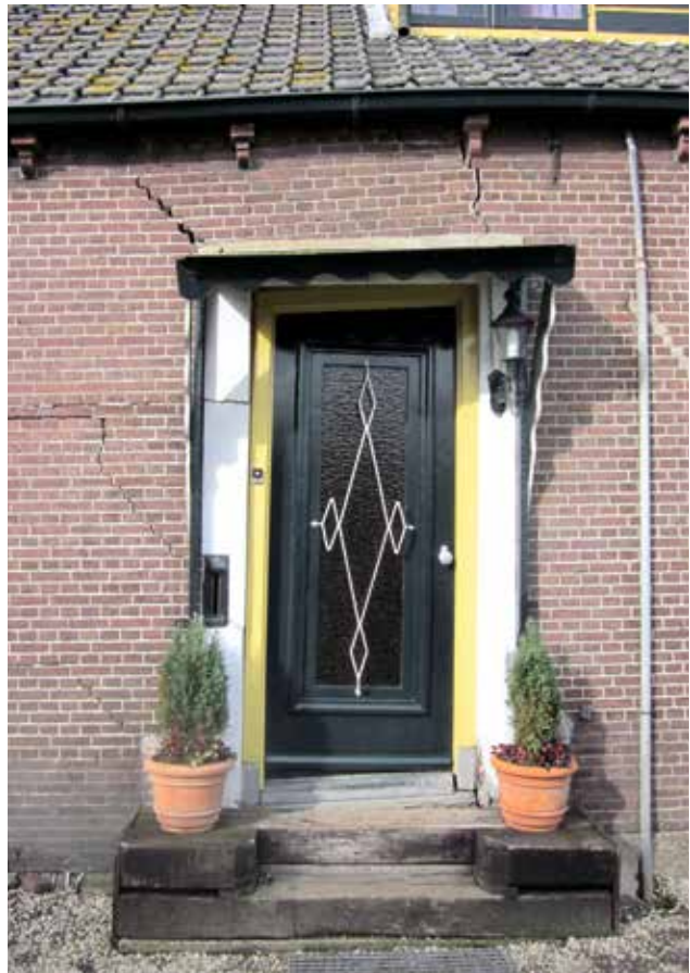
Schade door te lage grondwaterstand.
