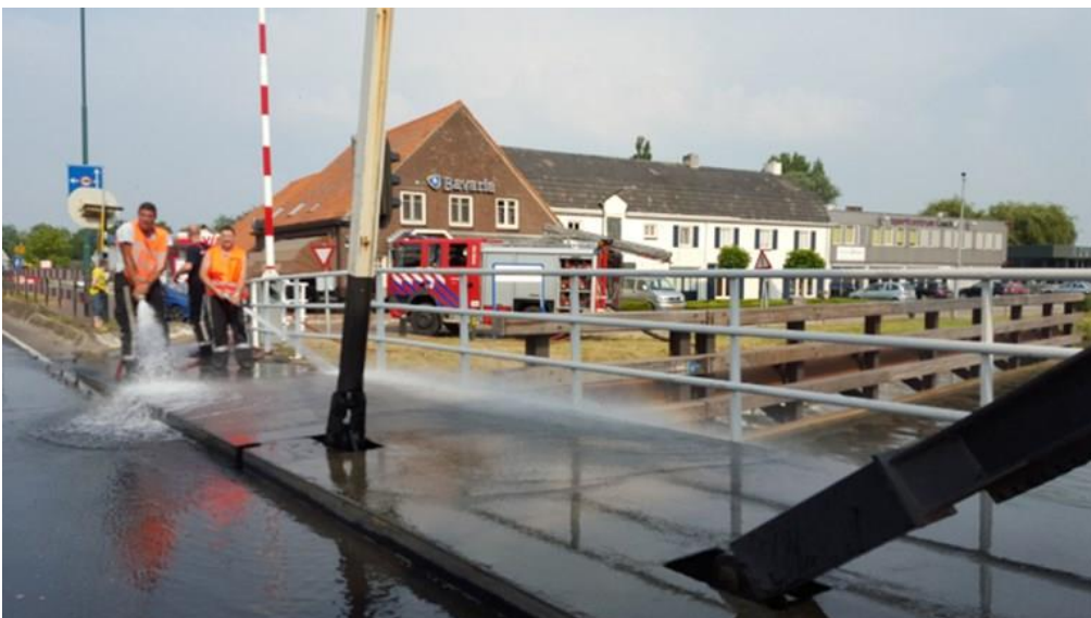
Figuur 26 - De 'Beekse brug' over de Zuid-Willemsvaart moet tijdens hete zomer worden afgekoeld om ervoor te zorgen dat hij kan sluiten, zo ook op deze foto uit 2015 (bron: Omroep Brabant).
