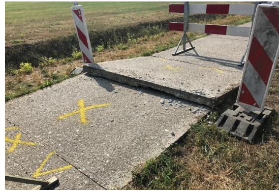
Figuur 21 Wateroverlast onder viaduct Milhezerweg onder de N270 (links) en opgedrukt fietspad door hitte Bakelseweg (rechts)
