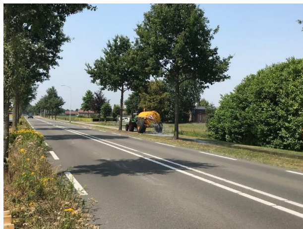
Figuur 16 Water en/of zout strooien voor koeling van wegen
