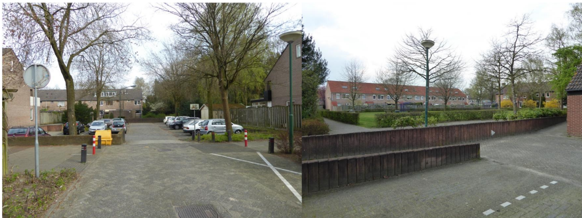
Afbeelding 15 Linkse foto: Verlaagde verkeersvoorzieningen in de wijk. Rechtse foto: Obstakels voor afstromend hemelwater en een profiel waarbij de groenvoorziening het hoogste punt in het profiel is.
